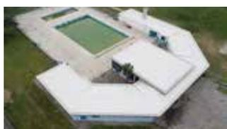
pertura con lastre di fibrocemento tipo amianto per una superficie pari a 500 mq. circa. Grazie ai fondi ottenuti, si è provveduto alla sostituzione di lastre di copertura (superficie in pianta esterno gronda per compenso con pendenze e sfridi pari a 830 mq) in fibrocemento amianto e successiva posa di un pannello sandwich coibentato con la posa di una nuova listellatura in legno di sezione 5X4 poggiata sulla struttura esistente. Valore del progetto € 138.796
