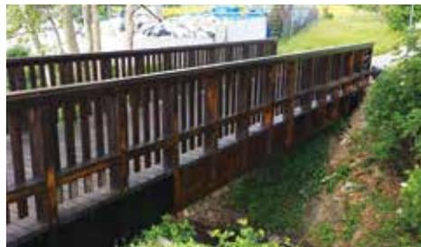
Il ponte in legno (2008) della ciclabile che prende inizio dalla via Persicana, ad una serie di controlli sulla struttura, ha rivelato condizioni tutt'altro che rassicuranti. Presentava un processo di deterioramento sulle travi centrali eccessivamente precoce e grave. Pertanto si è stati costretti ad intervenire. L'intervento è costato euro 4.500.
